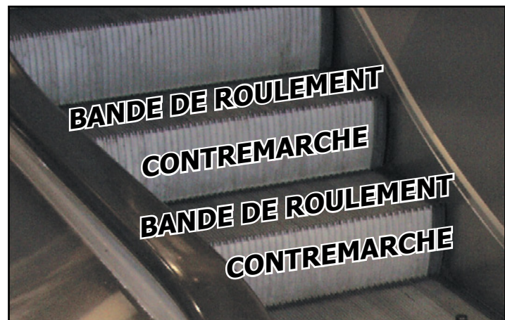
Figure 10. La paroi verticale de l'escalier mécanique est la contremarche
