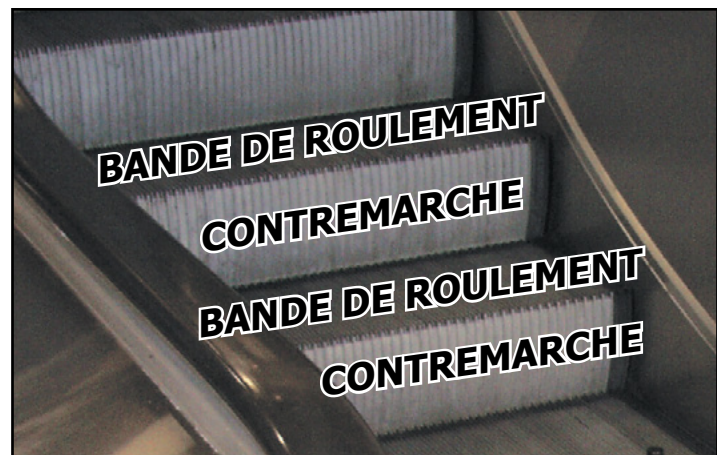
Figure 16. La paroi verticale de l'escalier mécanique est la contremarche
